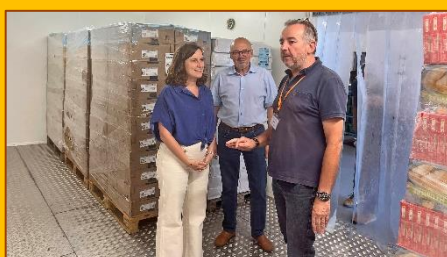
Une chambre froide
