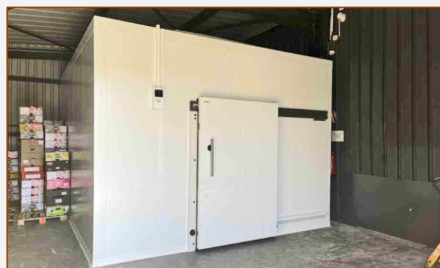
La nouvelle chambre froide
