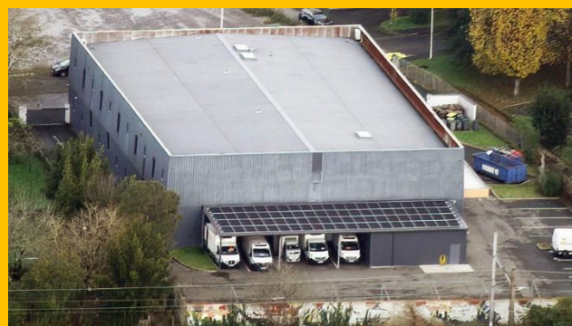
Les panneaux solaires sur le toit du garage
